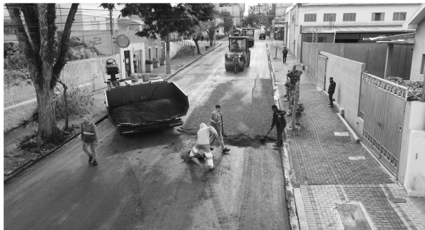
Recape na rua Irmã Eleutéria abrange trecho de três quadras FOTO: TRIBUNA
