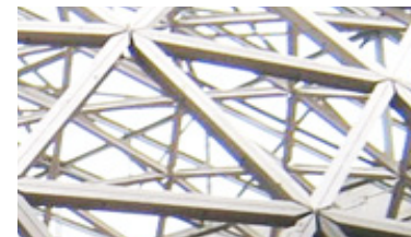
E Trelça metálica com chapas microperfuradas revestidas de resina
